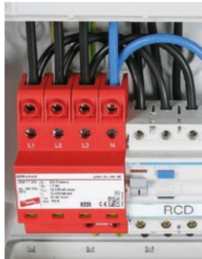
DEHNshield med V-kopplingsklämma
