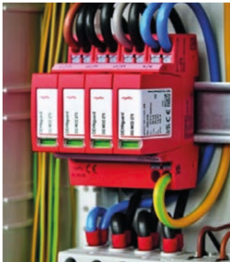
DEHNGuard push-in teknik med dubbla anslutningar
